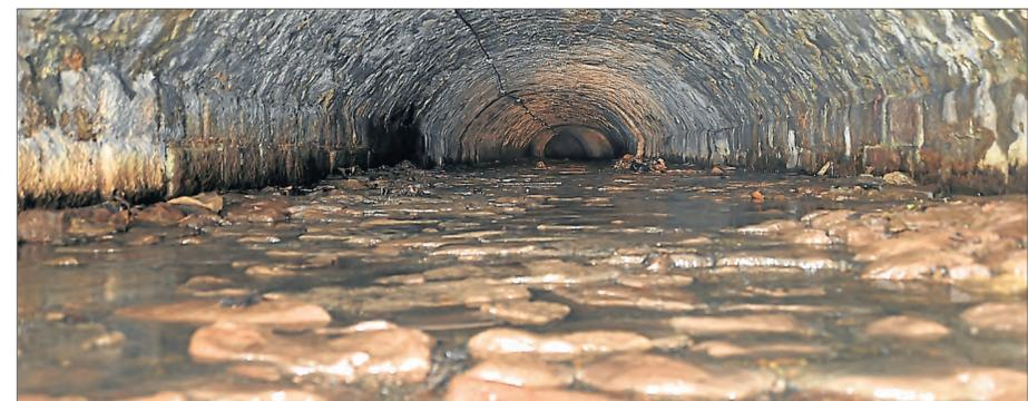
Das Regenwasser, was durch den Waidestunnel läuft, ist klar und sauber. Bei Starkregen kann es schon einmal vorkommen, dass der etwa zwei Meter hohe Tunnel komplett vollläuft.
