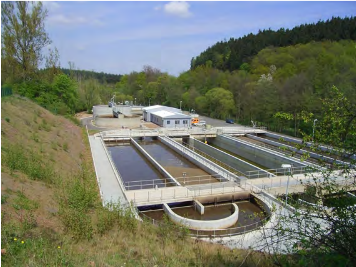
Kläranlage in Petersberg-Marbach (23.000 EW)
