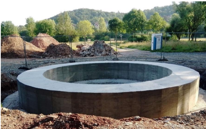
Die fertige Pressgrube für die Unterquerung der Fulda
