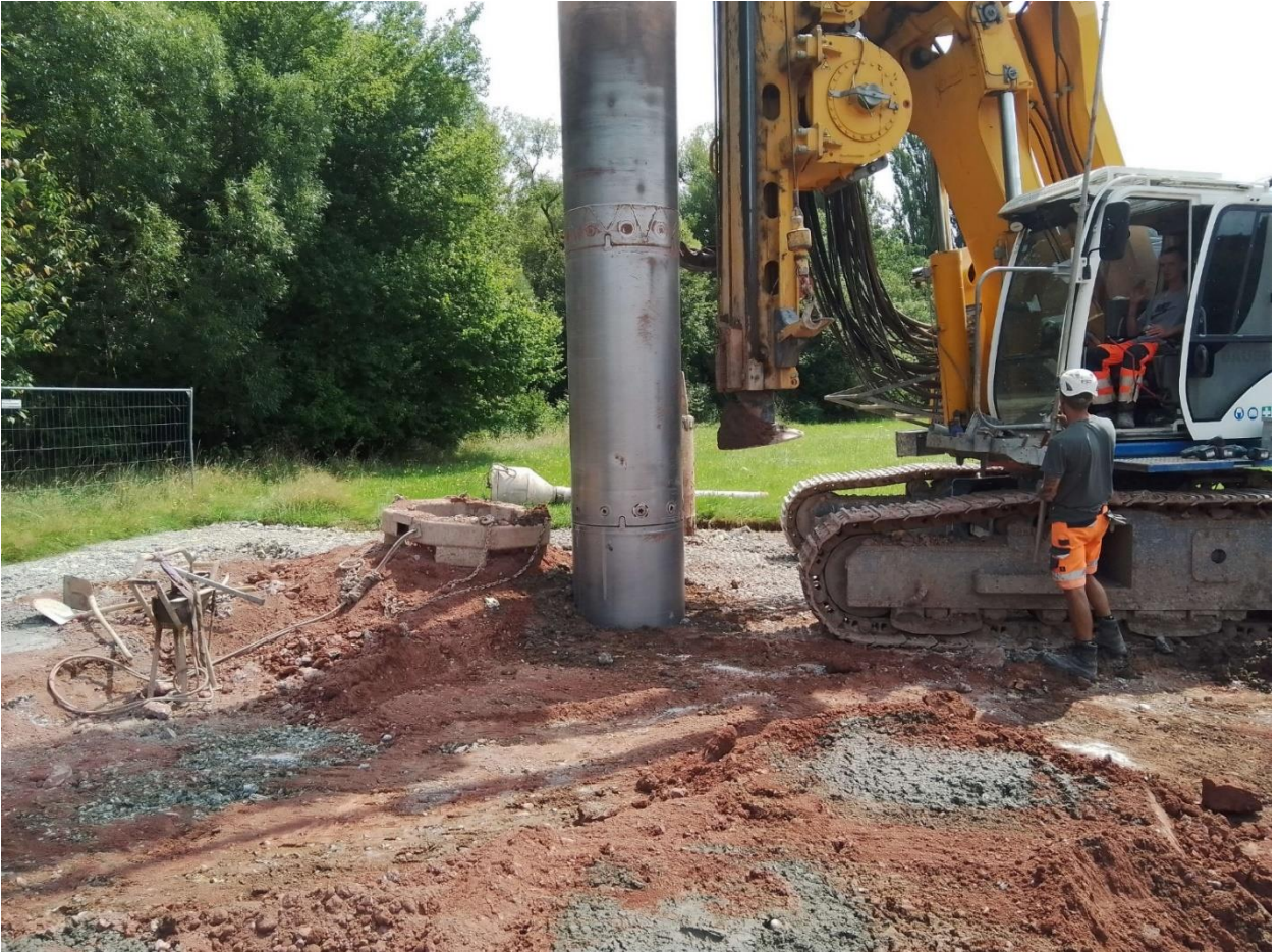
Niederbringung der „Großbohrpfähle“
