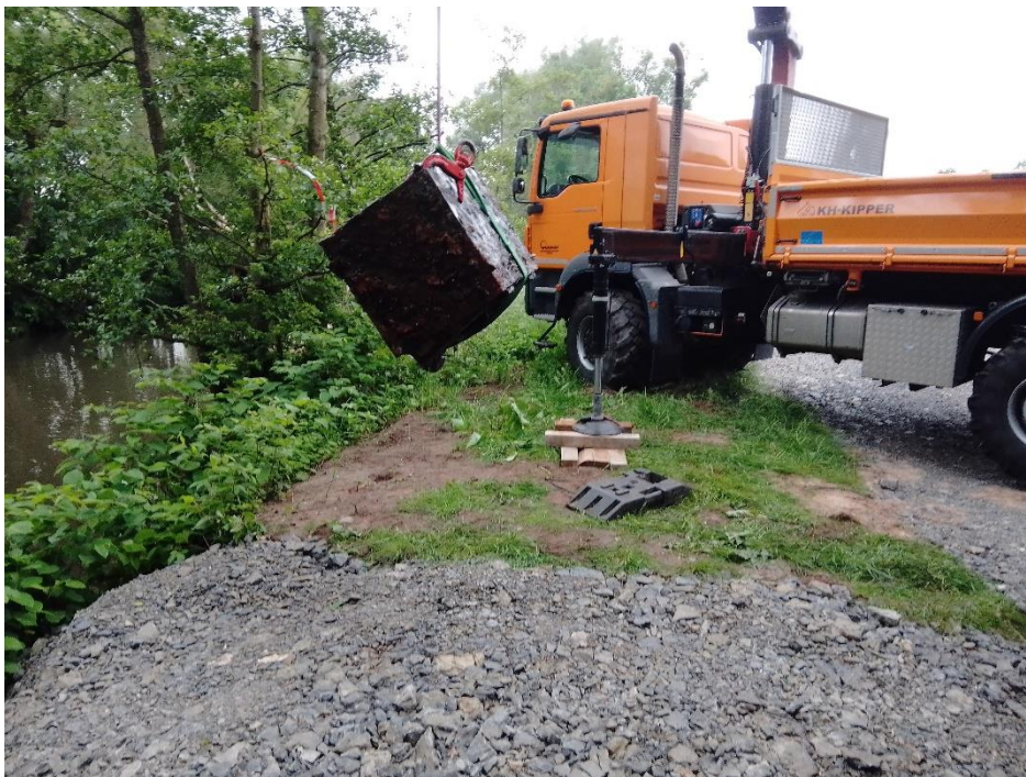
Bergung Tresor (Foto: Abwasserverband Fulda)
