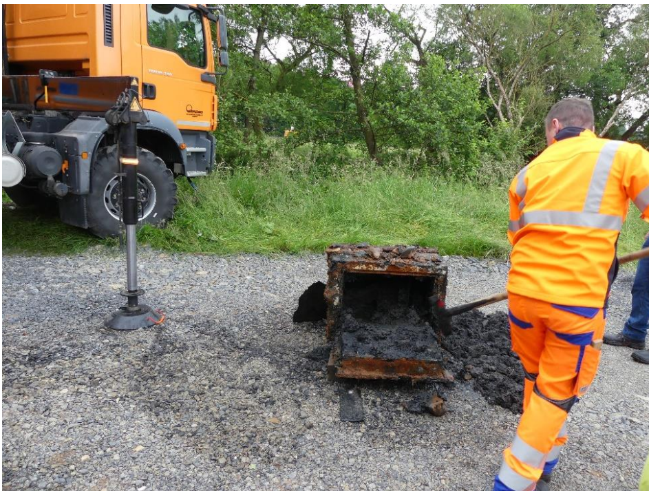
Räumung des Tresors (Foto: Abwasserverband Fulda)
