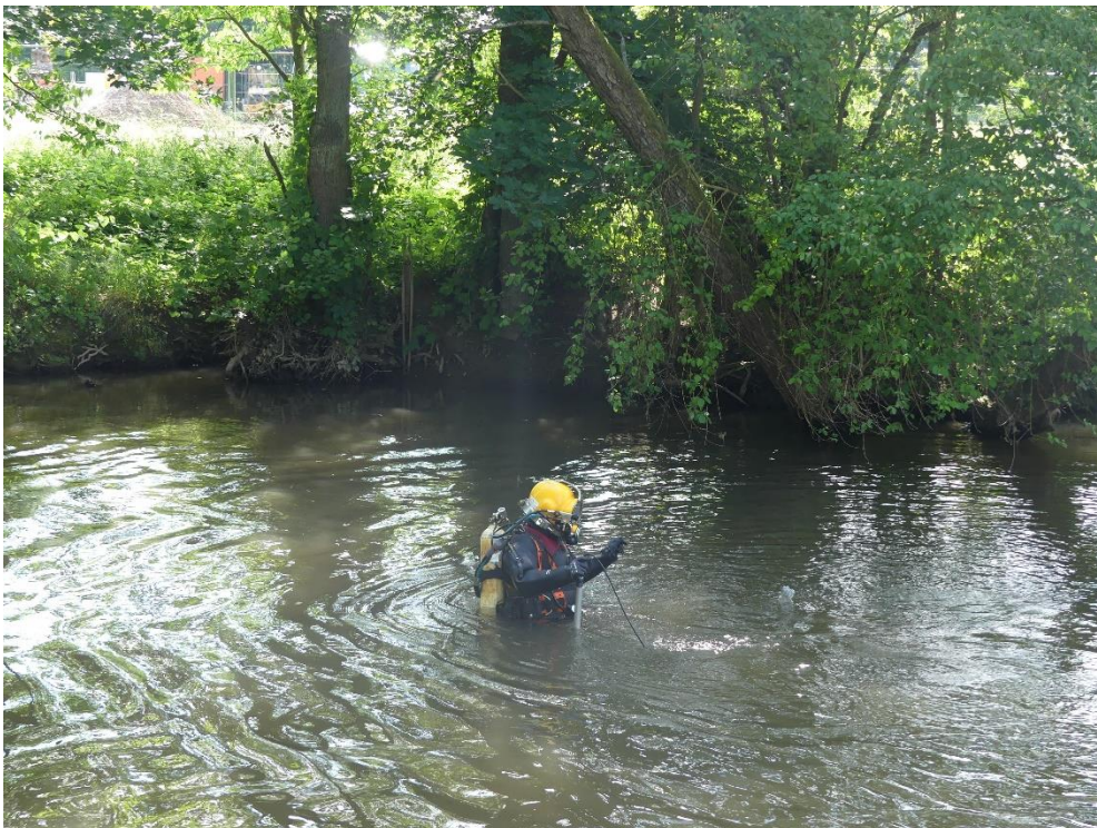
Tauchgang in der Fulda (Foto: Abwasserverband Fulda)
