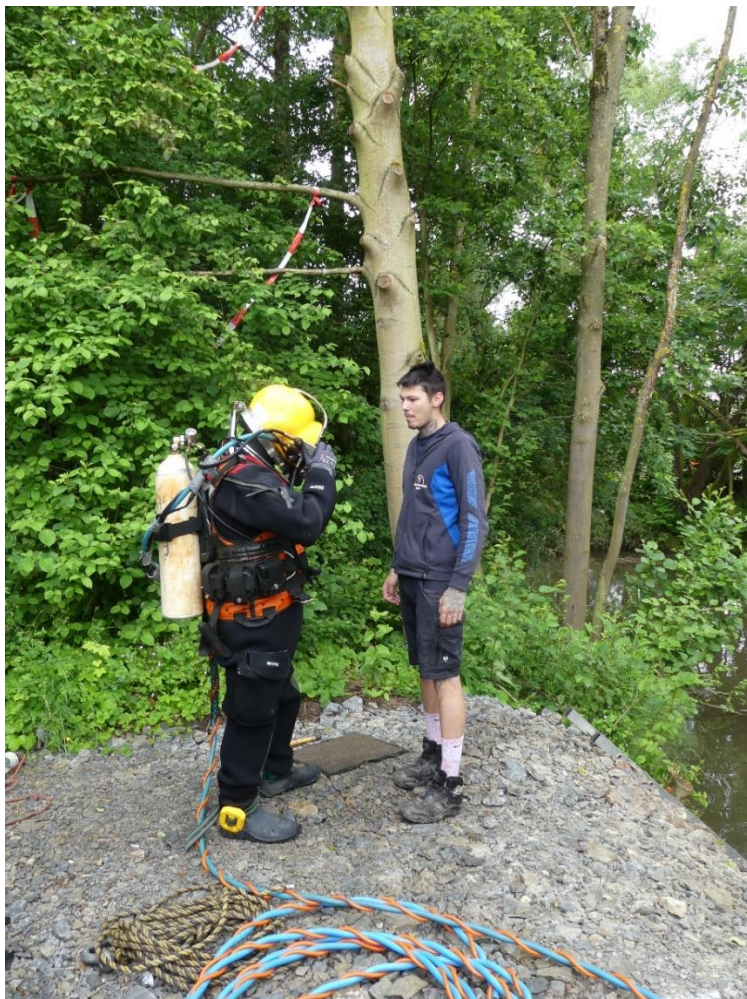
Vorbereitung des Tauchgangs (Foto: Abwasserverband Fulda)
