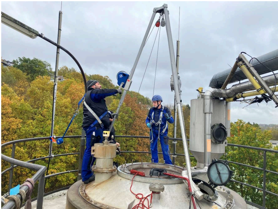
Sicherungswinde an der Spitze des Faulturms
