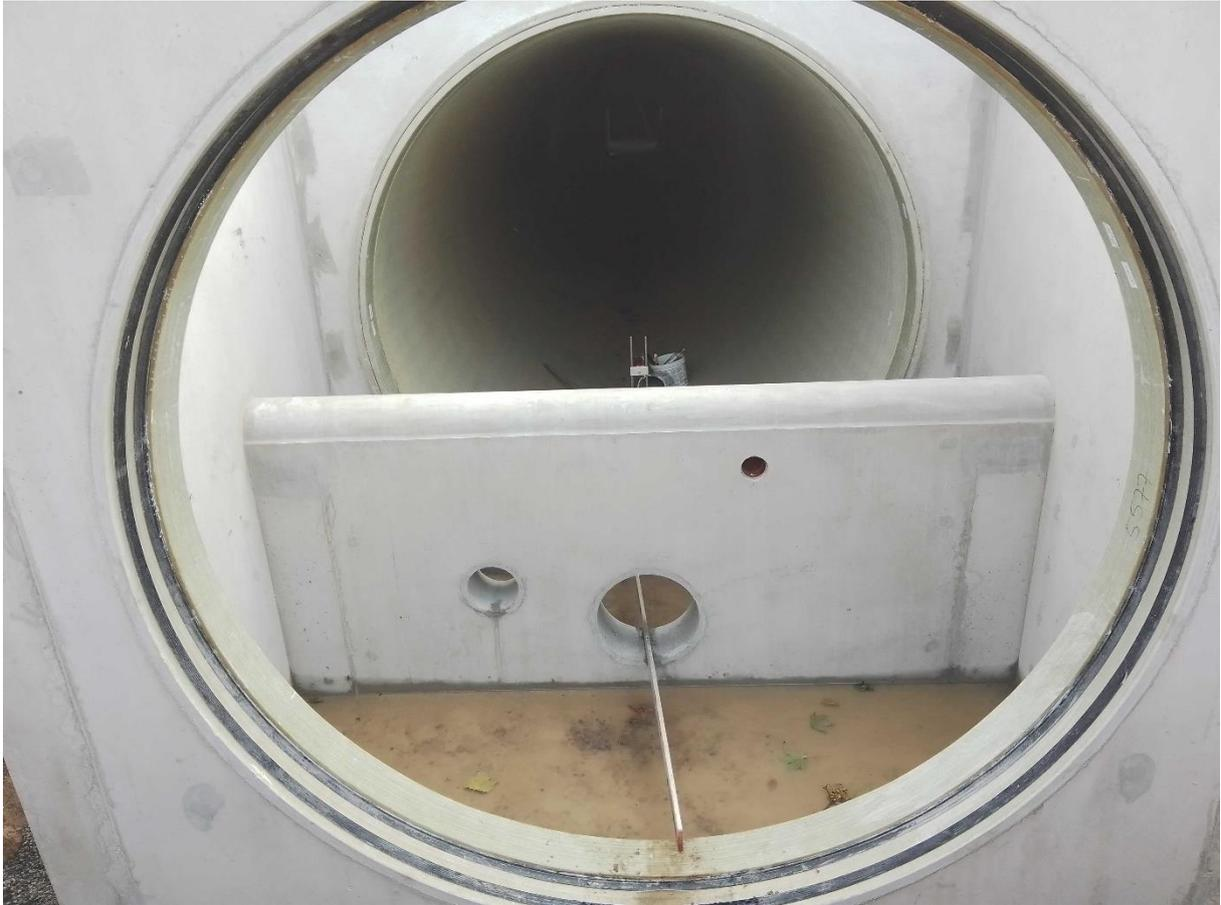
Die automatische Spüleinrichtung reinigt den Kanal mehrmals täglich mit einer Schwallspülung. Foto: Abwasserverband Fulda
