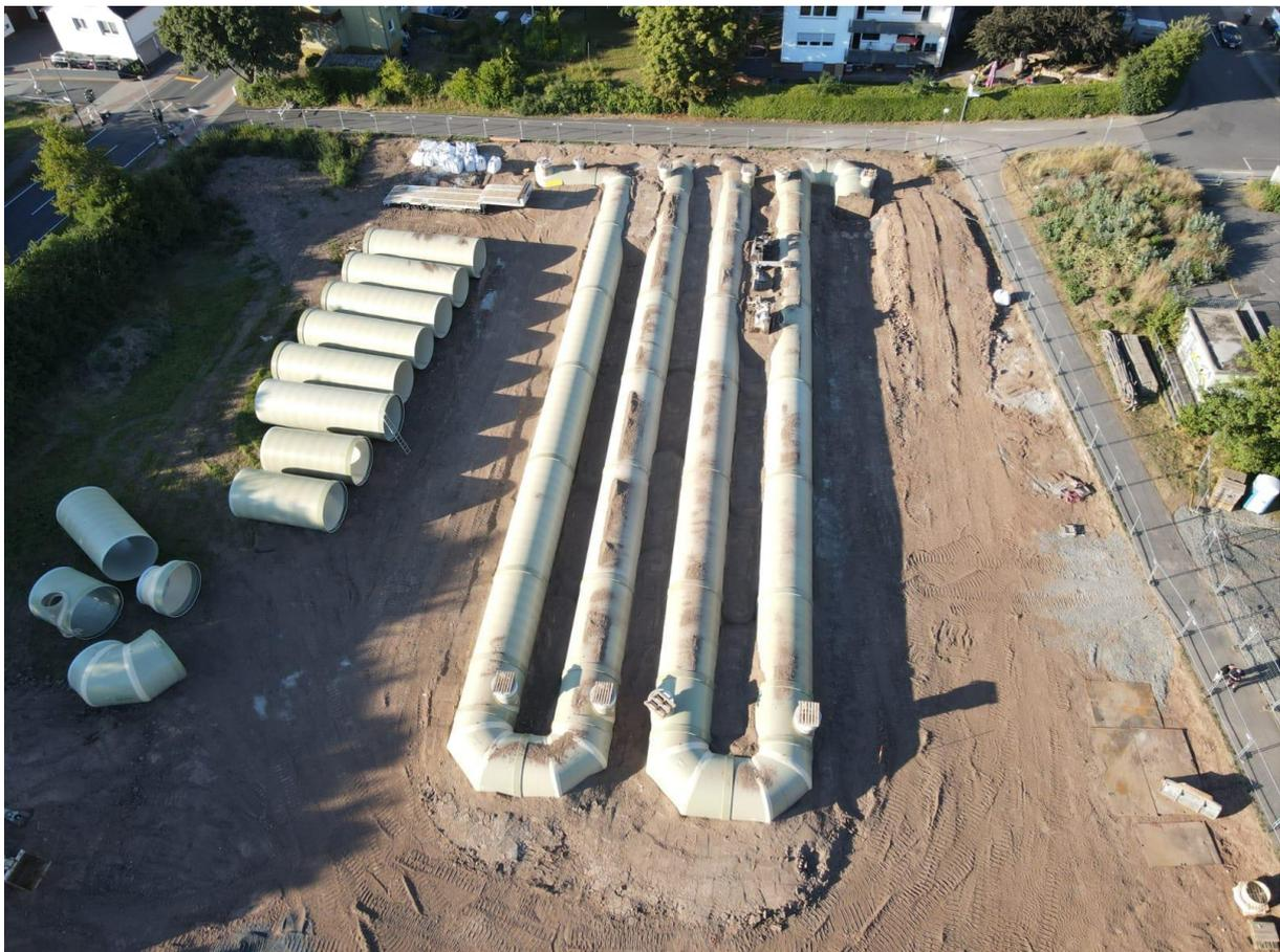
2300 Kubikmeter Stauraum platzsparend verlegt: Der Bau des Kanals aus der Vogelperspektive. Foto: Amiblu
