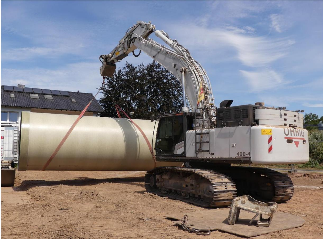
Handling der Rohre DN 3000 mit einer Baulänge von 8,75 Meter auf der Baustelle. Foto: Abwasserverband Fulda
